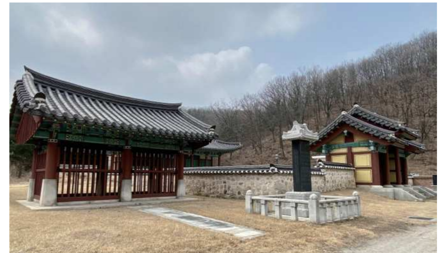
쌍정문과 함열 남궁씨 재실 전경
